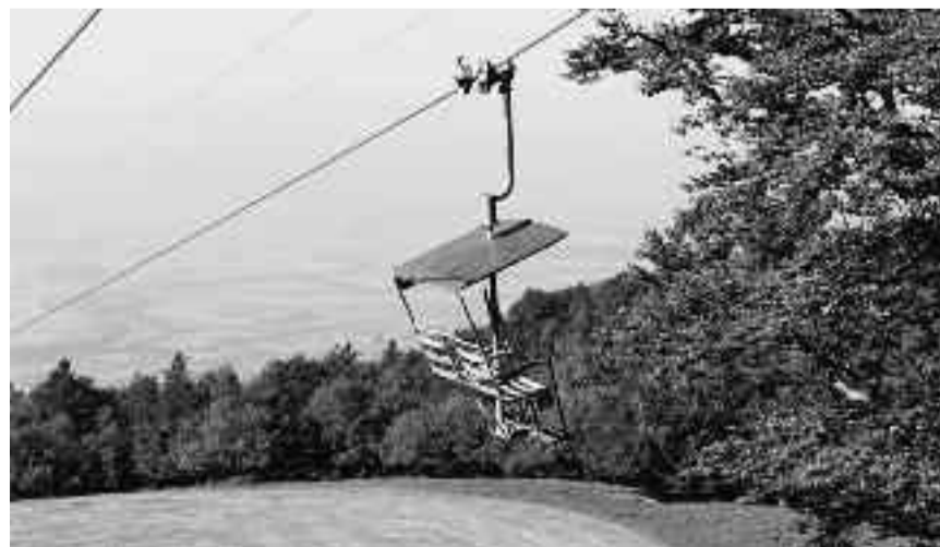
Der Sessellift Weissenstein SO ist eine der letzten erhaltenen Anlagen aus den Anfangsjahren des Sesselliftbaus in der Schweiz und soll mit Schoggitalergeld saniert und wieder in Betrieb gestellt werden Foto: pd
